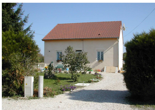
Exemple de réhabilitation (travaux intérieurs et extérieurs) d'un logement locatif à Trugny, ayant bénéficié des aides dans le cadre de l'OPAH
